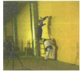
墨出し割付け
